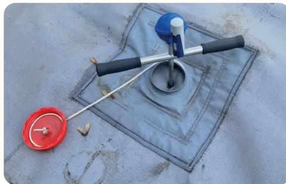
**FOTOGRAFÍA 14:** Sensor de temperatura fijo
